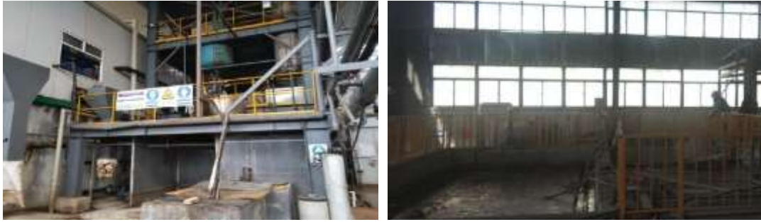
图 4-1 原有污水处理站
