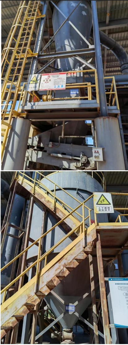
旋风除尘器+布袋除尘器
