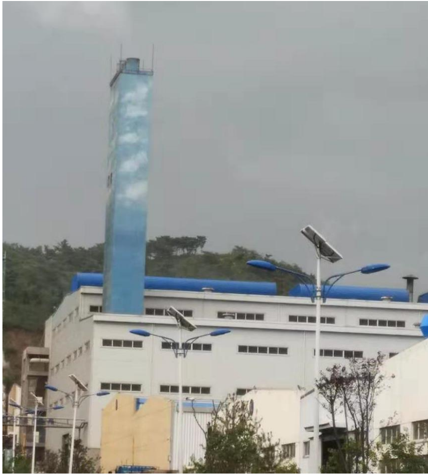
回转窑废气 P1 排气筒
