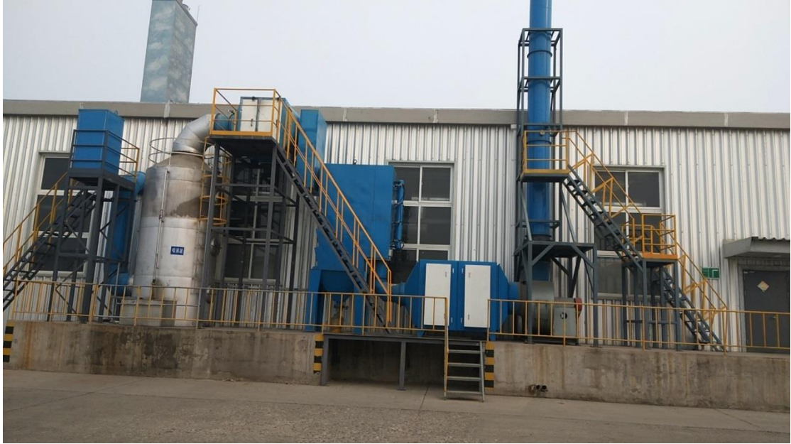
喷淋塔+滤筒除尘+低温等离子+光氧催化+活性炭+P3 排气筒及采样平台
