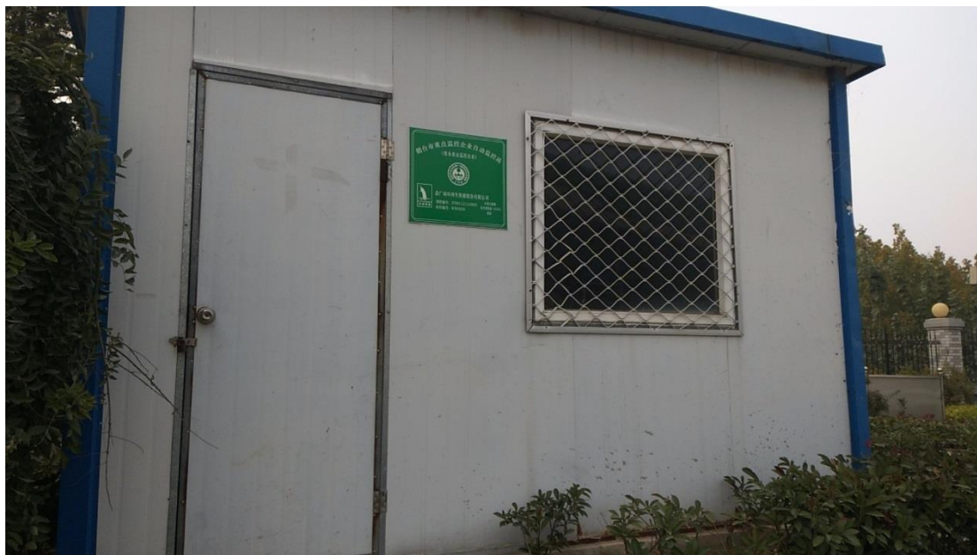
图 7.3-2 厂区在线监测系统
